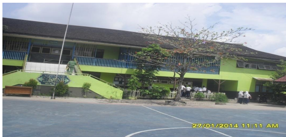
Gambar 4.1 Keadaan Sarana dan Prasarana MTs Al-Ikwan Banjarmasin
